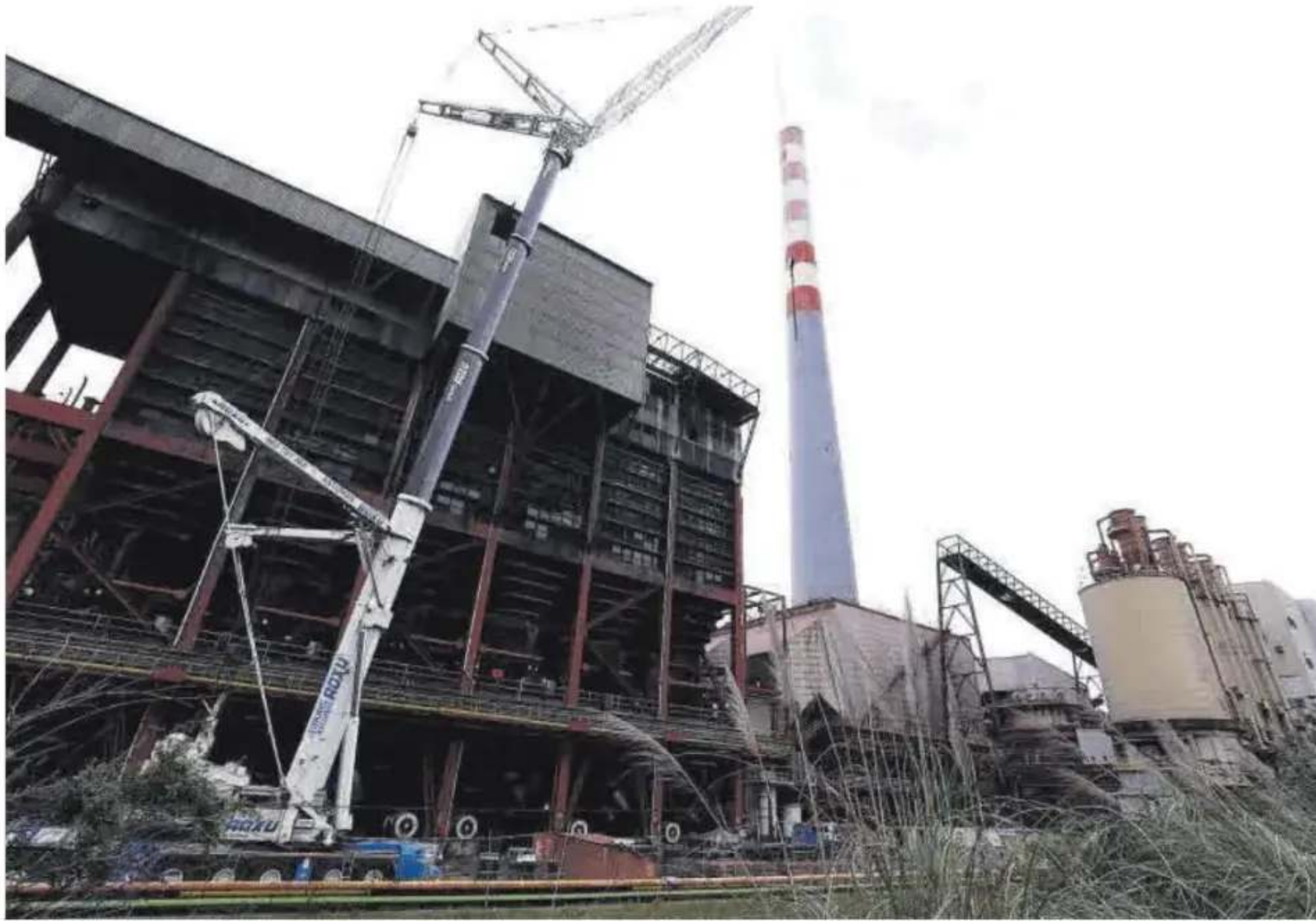
La grúa que ayuda en la reforma de la caldera del grupo 2 de la térmica de Aboño.
